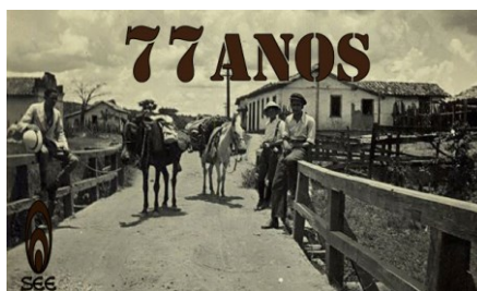
Partida para a fazenda Bom Jardim Ponte sobre o Ribeirão da Mata
