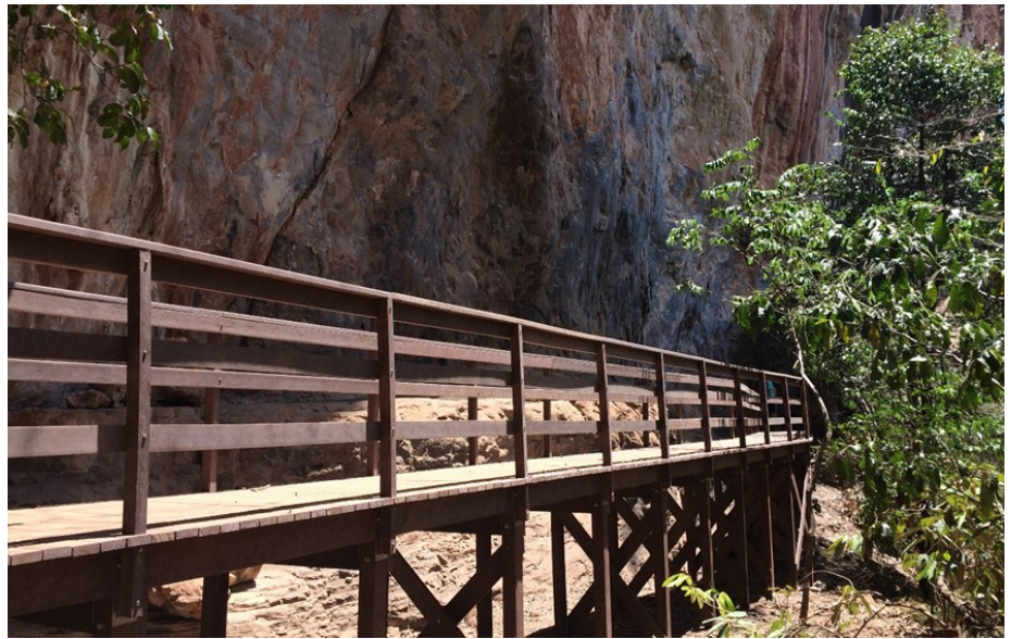
Passarela em madeira plástica já construída na entrada da Gruta do Janelão
