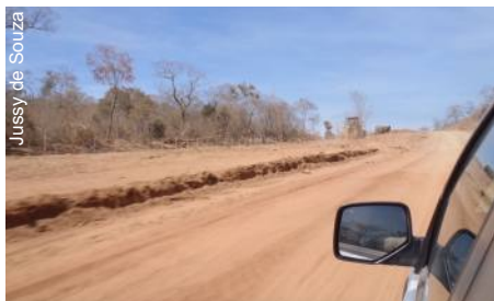
Obras sobre o carste de São Desidério
