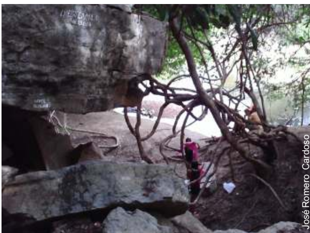
Sem educação: pichações e lixo degradam o local
